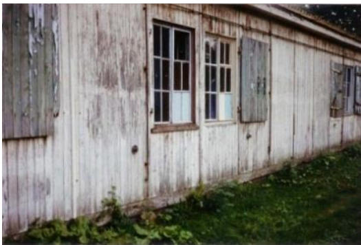
Vue de l'arrière du bâtiment.
