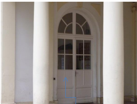
Entrée chef de Poste et planton(s)
