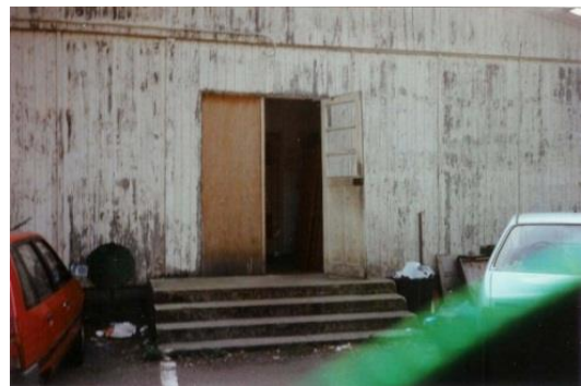
Vue de l'entrée, côté Parking.
